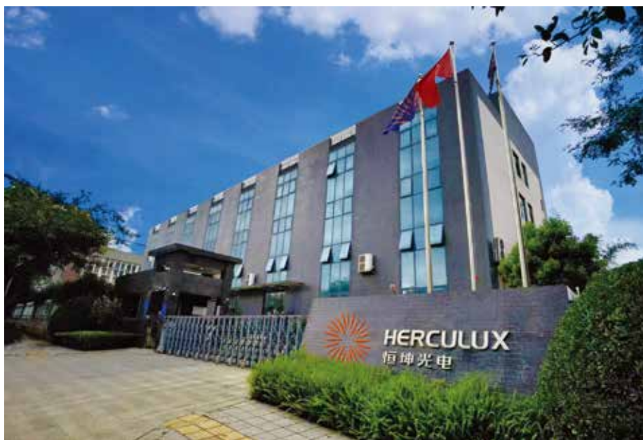
成都双流区自建超20000 m 2 恒坤光电园
